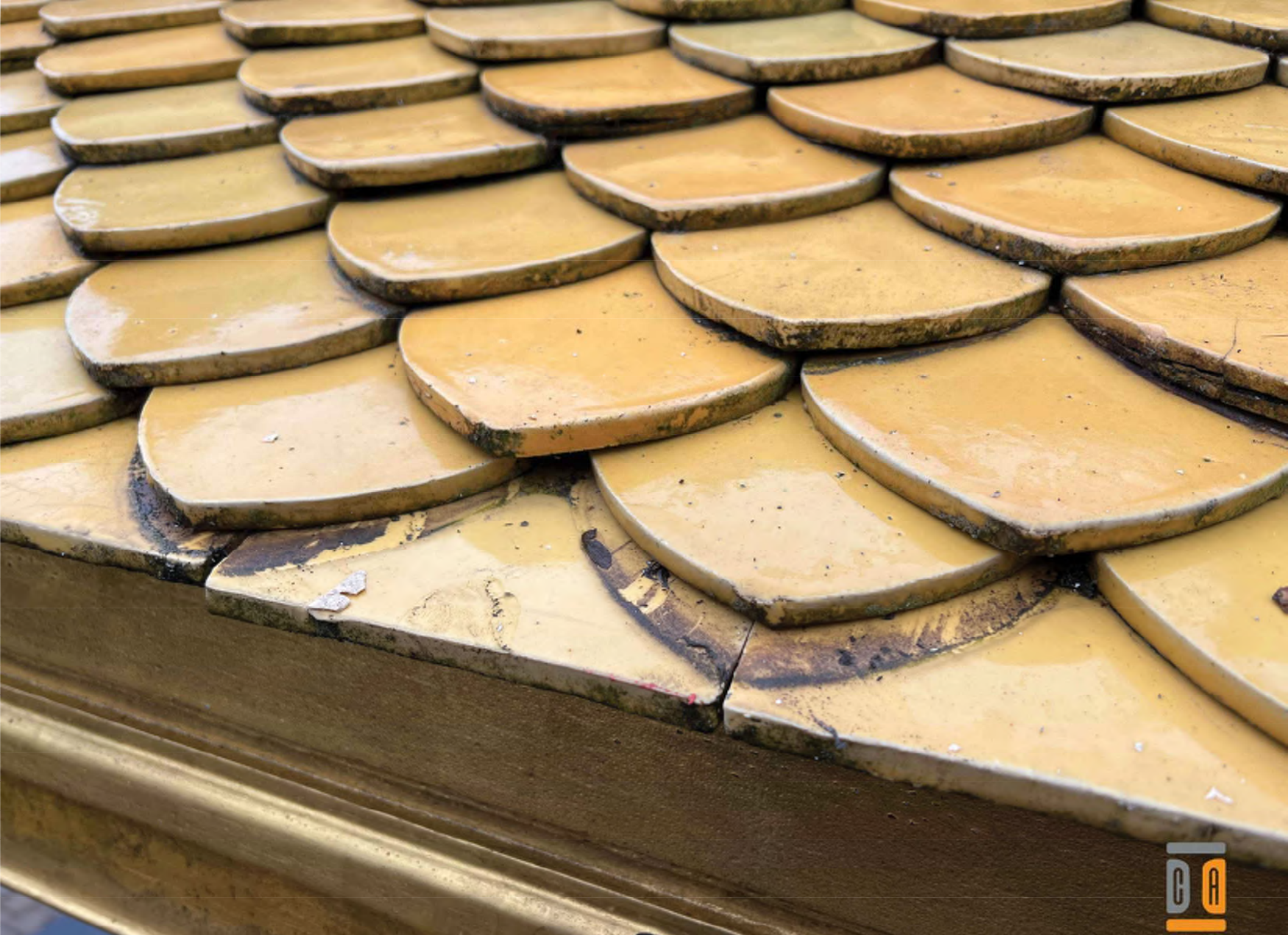
13. Displaced tile - broken lug - Priority 1
